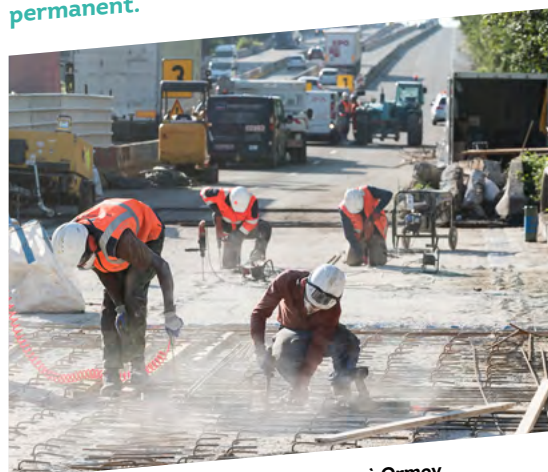
Rénovation du pont de l'A6 sur l'Essonne à Ormoy.
