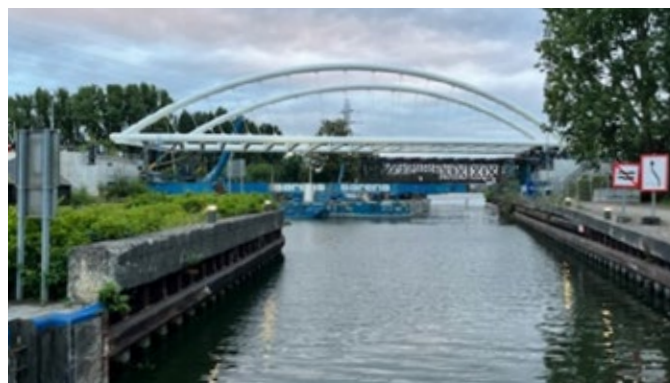
*Pont de type « Bow-string » : pont muni d'un tablier (tirant) et de poutres latérales (en arc au-dessus du tablier) qui sont encastrés l'un dans l'autre aux extrémités. En travée, le tablier est tenu par des suspentes souvent à la verticale.
