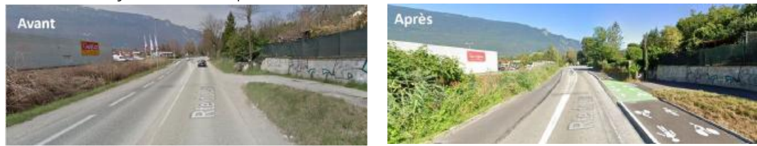
Figure 118 Aménagement cyclable en accotement avant et après : transformation d'une voirie existante CC Grand Lac
